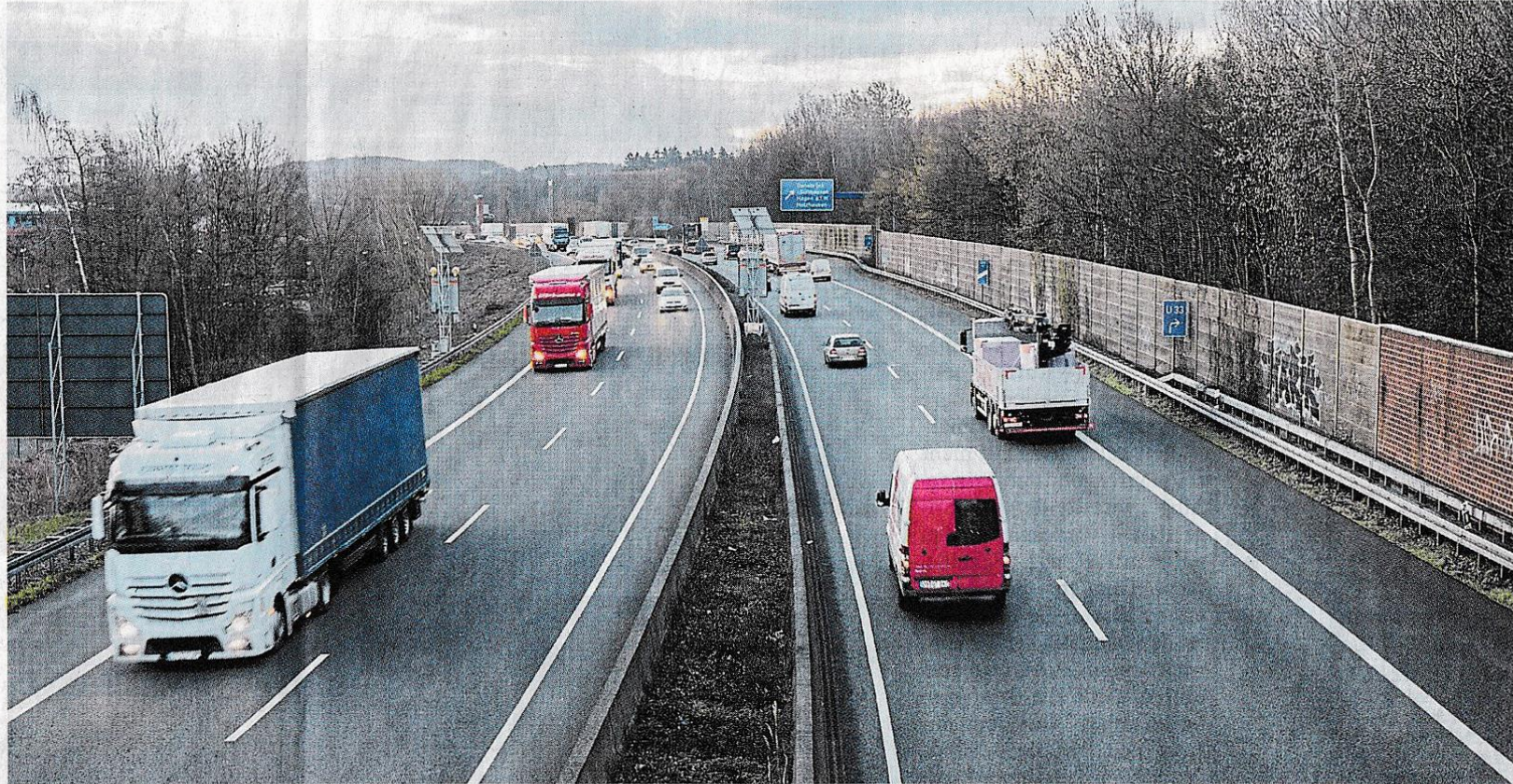
In zehn Jahren sechsspürig? Der Vorentwurf für den Ausbau der A30 (hier zwischen Nahne und Sutthausen) ist so gut wie fertig.
